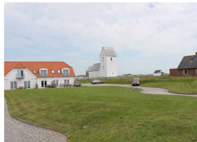
Ferring Kirke og ferieboligerne, der er opført på badehotellets grund.
